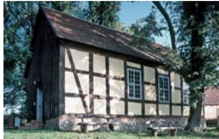
Fachwerkbau bei einer Kirche in Glambeck (Barnim), die denkmalgerecht und ökologisch saniert wurde.
