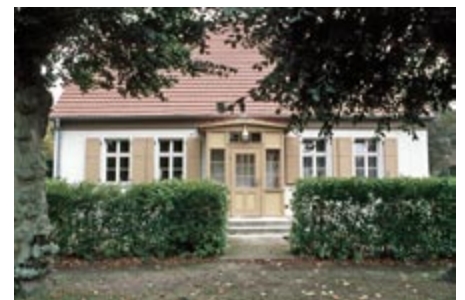
Hohensaaten – Sanierung Alte Schule
