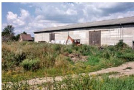
ehemalige LPG – Anlage, Landwirtschaftsbetrieb Ortlieb, Neugrinnitz Für landwirtschaftlich genutzte Gebäude kann es neue Möglichkeiten der Gestaltung und Nutzung geben.
