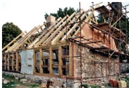
Die Sanierung dieses Hauses in Hohenfinow (Barnim) erfordert Kenntnisse regionaltypischer Bauweisen wie die des Feldsteinbaus.
