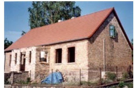
Sanierung eines Wohnhauses, Ulrike Amooore, Brodowin (Barnim)
