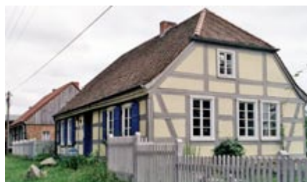
Sanierung eines denkmalgeschützten Wohnhauses, Beate Dapper, Poratz (Uckermark)
