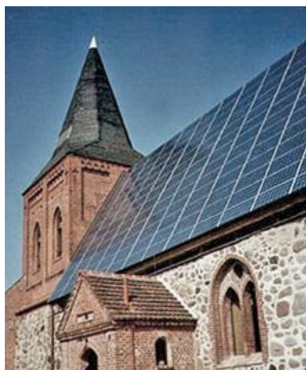
Fotovoltaikanlage auf der Kirche Zernin (Mecklenburg-Vorpommern) Quelle: www.kirche-tarnow.de
