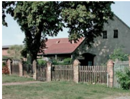
Zaunpfeiler aus Ziegelmauerwerk in der Uckermark
